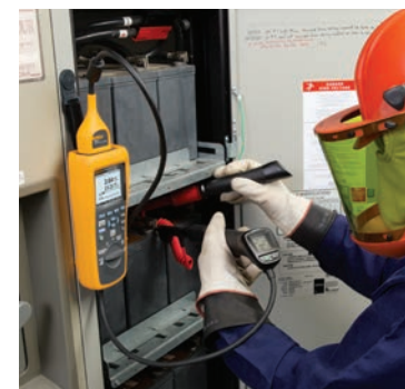
Mål impedans med Fluke BT521 batterianalysator.
