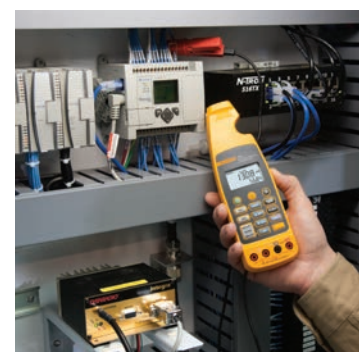
Mål prosess- og andre automatikksignaler på 4 til 20 mA uten å bryte sløyfen.
